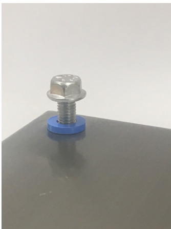
Écrou à encastrer pour la fixation du couvercle
