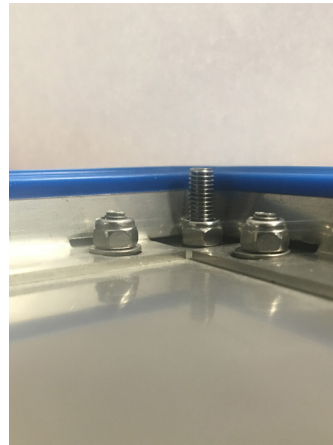
Innenansicht Deckel / Verliersicherung
